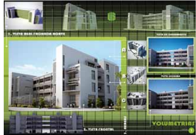
FIGURA 1. Edificio de Investigaciones de la UIS situado en el Parque Tecnológico de Guatiguará, Fuente: Vicerrectoría de Investigaciones - Universidad Industrial de Santander
