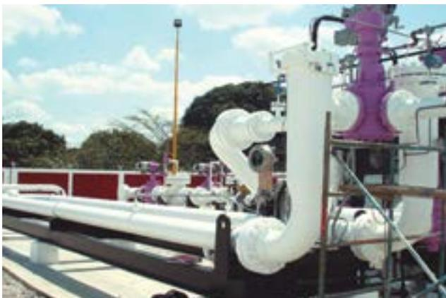
Figura 2. Probador de desplazamiento mecánico<sup>8</sup>
