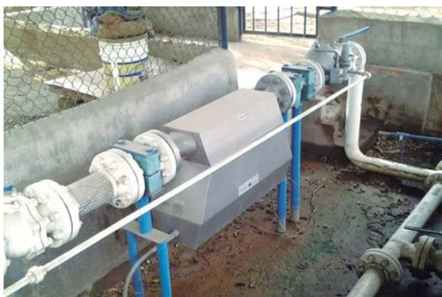
Figura 1. Medidor másico tipo Coriolis para recibo de GLP por poliducto<sup>2</sup>
