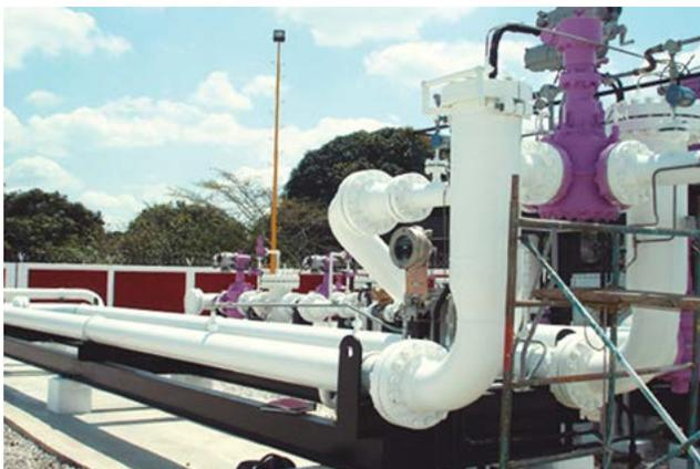
Figura 2. Probador de desplazamiento mecánico<sup>8</sup>
