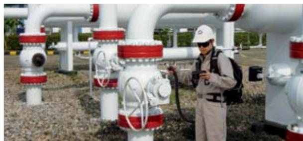
Figura 3. Detección de fugas utilizando una cámara infrarroja (arriba) y medición de fugas utilizando el muestreador de alto volumen (abajo)
